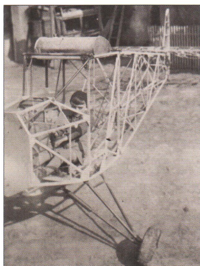
Obdobný pohled na dřevěnou (nahore) a kovovou kostru trupu
